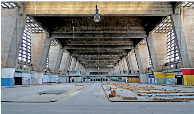
Bild 4 Großmarkthalle Frankfurt, 1928 Central Market Hall Frankfurt, 1928
