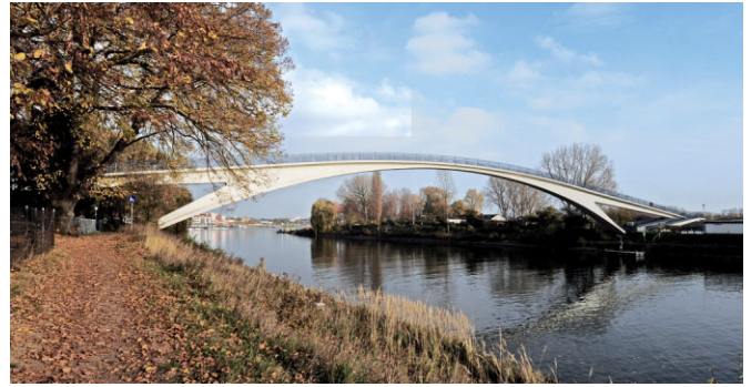
Bild 20 Schiersteiner Steg 1967 Footbridge in Schierstein
