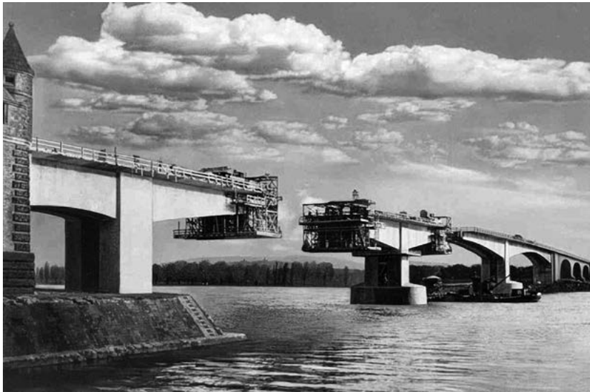
Abb. 13: Das mittlere und das linke Feld kurz vor dem Zusammenschluss.
