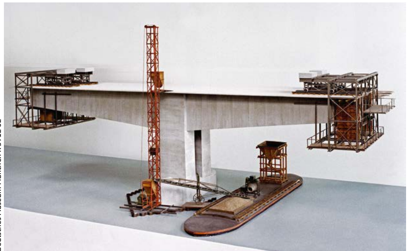
Abb. 9: Modell vom Bau der Nibelungenbrücke mit den Vorbauwagen im Deutschen Museum München.
