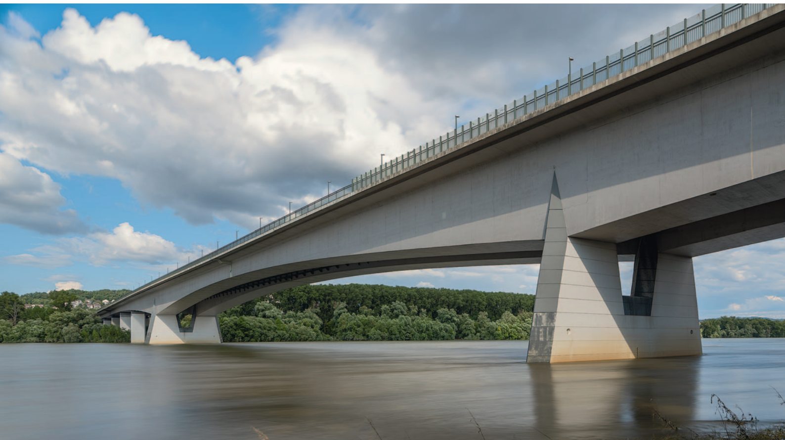
Abb. 5: Die vom Abriss gefährdete Rheinbrücke Bendorf (1962–1965) führt die Autobahn A 48 über den Rhein
