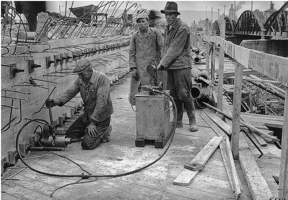
Abb. 8 b: Bauarbeiter beim Vorspannen der Stahlstäbe einer Brücke mit dem hydraulischen DYWIDAG-Spanngerät
