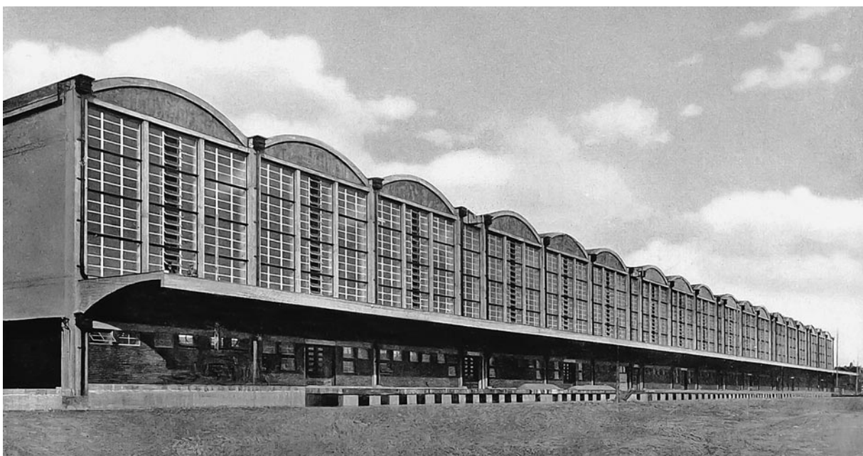
Abb. 3: Die von Finsterwalder ähnlich wie die Großmarkthalle in Frankfurt am Main konzipierte Großmarkthalle in Budapest wurde 1932 eingeweiht
